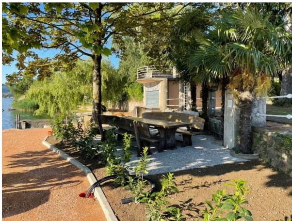
3 - Camminamento “passaggio a riva” con finitura in calcestre, massi di coronamento a raso e letto di frega a Brusimpiano - post intervento
