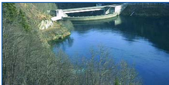
2003, svuotamento del bacino di Palagnedra, primo piano dei fanghi (foto: Officine idroelettriche della Maggia).
